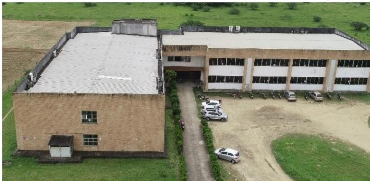
Figura 1 – Vista da fachada sul da edificação.
