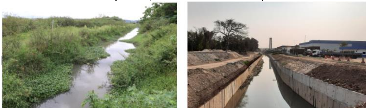
Figura 1 - Foto da esquerda: Trecho do córrego do Tanquinho antes da canalização. Foto da direita: Trecho do córrego do Tanquinho durante a obra de canalização.
