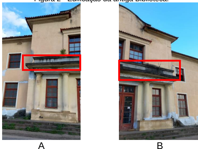
Figura 2 - Edificação da antiga Biblioteca.
