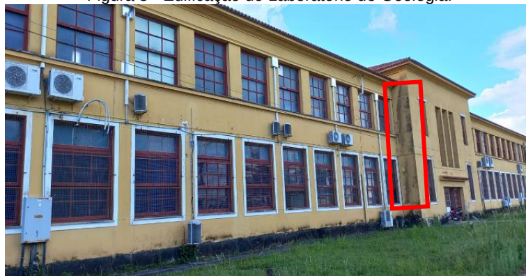
Figura 3 - Edificação do Laboratório de Geologia.
