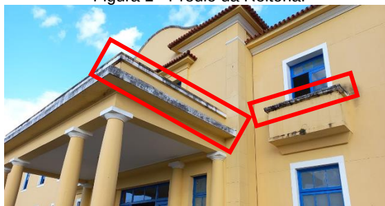
Figura 1 - Prédio da Reitoria.
