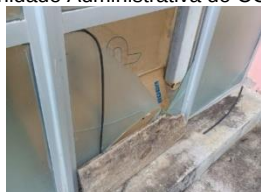
Figura 13 - Caixa acoplada com tampa quebrada do banheiro masculino do Prédio de Laboratórios do CETEC.
