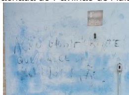
Figura 7 - Riscos em caneta na pintura da fachada do Pavilhão de Aulas 2.
