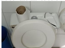
Figura 13 - Caixa acoplada com tampa quebrada do banheiro masculino do Prédio de Laboratórios do CETEC.
