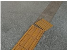
Figura 14 - Piso tátil solto no pátio do Prédio de Laboratórios do CETEC.
