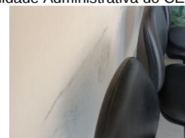
Figura 6 - Marcas de fita adesiva para colagem de avisos e anúncios na parede do Pavilhão de Aulas 1.
