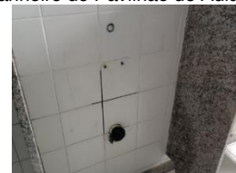
Figura 12 - Remoção de acessório em banheiro do Pavilhão de Aulas 2.
