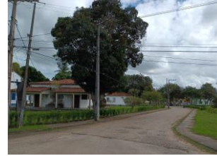
Figura 2 - Vista do local escolhido.
