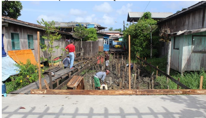
Figura 3 – Construção da travessia Quintino Bocaiuva em concreto.
