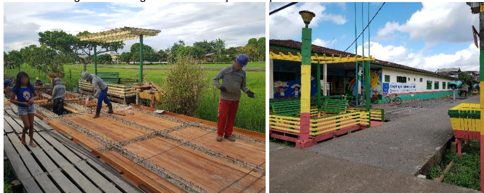
Figura 3 - Imagens da renovação das passarelas da cidade de Afuá
