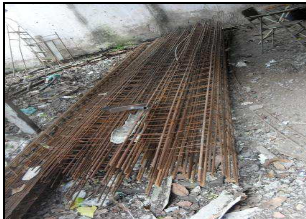
Figura 6 – Armazenamento de armações em aço. (EC-B).
