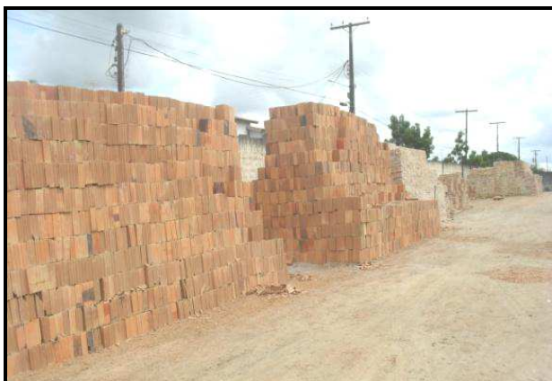
Figura 4 - Pilhas altas de blocos cerâmicos colocadas diretamente no chão, propício a queda sobre o trabalhador. (EC-A)
