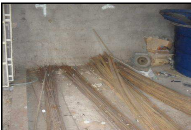
Figura 5 – Armazenamento de vergalhões em aço. (EC-B).
