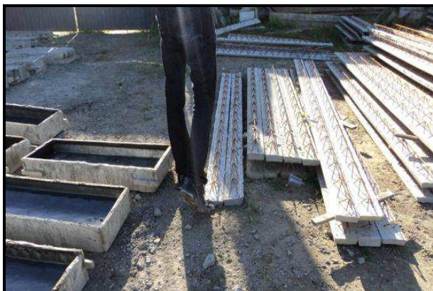
Figura 1 - Riscos de acidentes por causa de partes vivas de aço em local inadequado. (EP-A)
