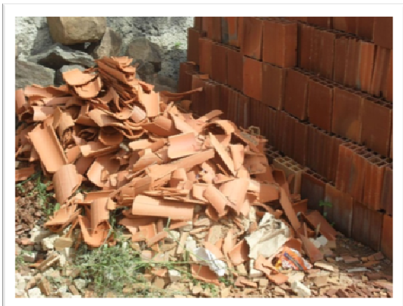
Figura 4 - Perda de telhas cerâmicas.
