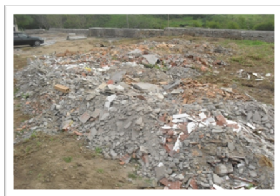
Figura 5 - Deposição de entulho no CO-C.
