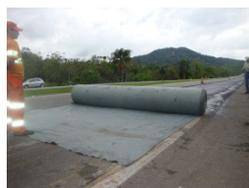
(d) Instalação manual da manta de geotêxtil não-tecido.
