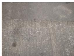
(a) Fresagem das trincas já executadas.
