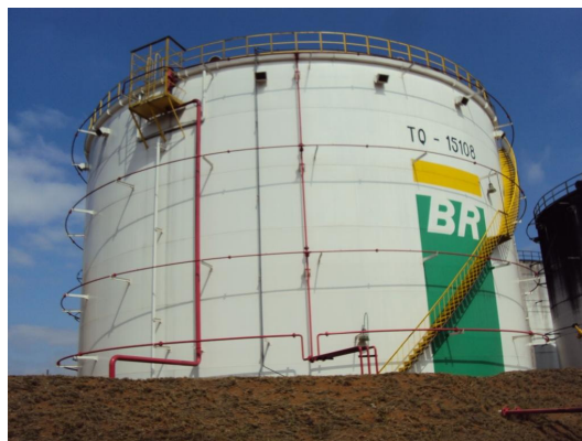
Figura 8 – Tanque de armazenamento de álcool com condutor pluvial após 01 ano da manutenção completa
