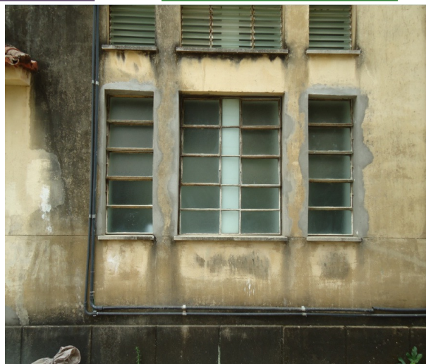
Figura 13 - fachada do prédio de química
