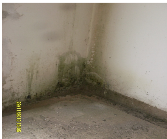
Figura 3 – Mancha de bolor no prédio do Centro de Ciências Exatas e Tecnológicas
