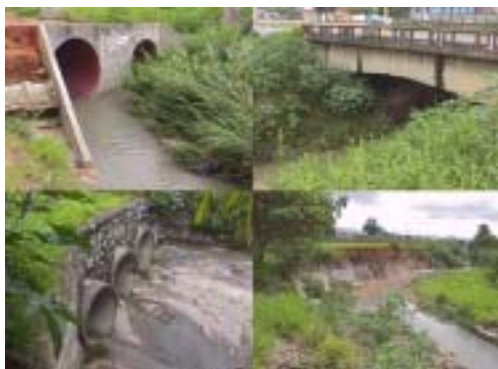
Pontos de restrição de vazão no município de São José dos Campos
