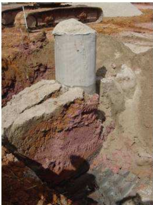
Figura 9: Coluna Granular Encamisada (Huesker, 2006).
