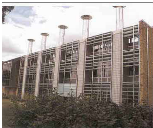
Figura 4 - O edifício do meio ambiente; 1º edifício do Reino Unido a incorporar a tecnologia de concreto usinado com a utilização de agregados reciclados (LEVY e HELENE, 2002).
