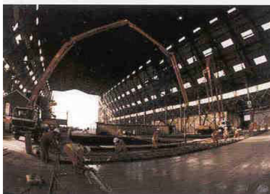
Figura 3- Piso de alta resistência do Laboratório de Cardinton construído especialmente para analisar o efeito causado por substituição em massa de 20% de agregados reciclados de concreto e alvenaria de baixa qualidade. (LEVY e HELENE, 2002).
