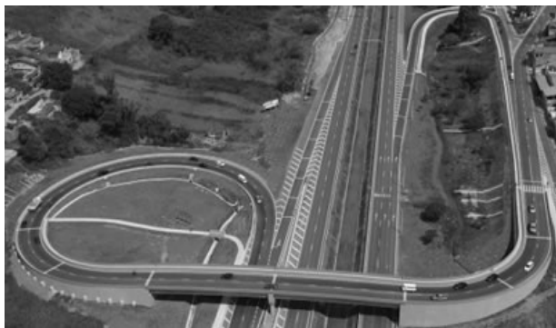
Figura 2. Viaduto Talim – Fase 1.
