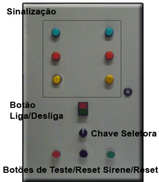
Figura 1- Quadro de comando elétrico da moto-bomba
