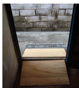
Figura 5: Rampa de madeira para degrau interno.
