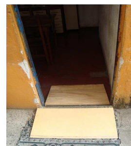
Figura 6: Rampa de madeira para degrau externo.
