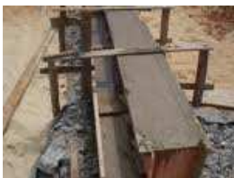
Figura 11- Moldagem de uma viga de concreto armado.
