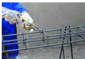
Figura 10- Confeção da armação de uma viga de concreto armado.
