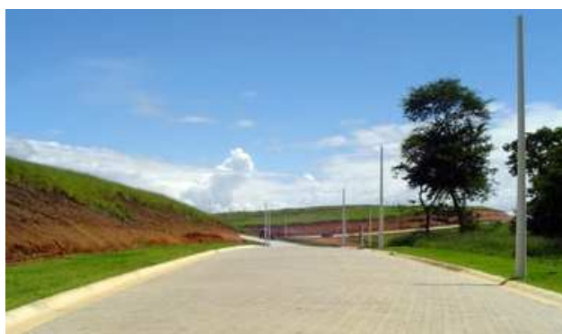
Figura 1– Pavimentação dentro do Condomínio
