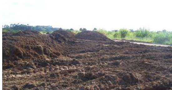
Figura 3 – cobertura de 30 cm de espessura com terra de barranco.
