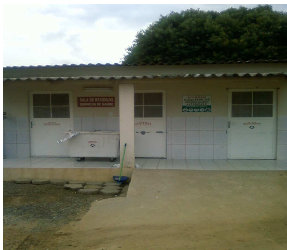
Figura 5. Sala de acondicionamento dos resíduos para destinação final.
