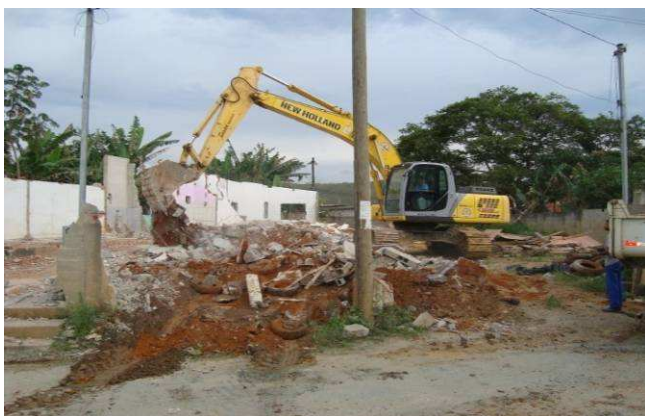
Figura 7 – Casas sendo demolidas Fonte: arquivo da Defesa Civil (2009).
