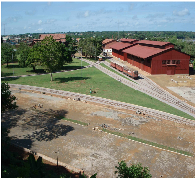
Figura nº 01 Praça da E.F.M-M. Galpão do Museu - Porto Velho(RO) 06/06/2010
