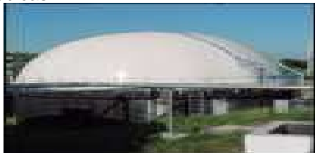
Figura 2 – Biodigestores de biomassa
