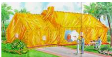
Figura 3 - Tratamento a gás.
