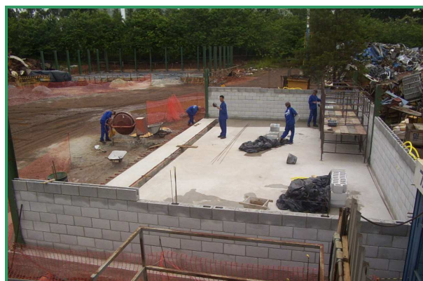
Figura 2 – Pósconcretagem da baía
