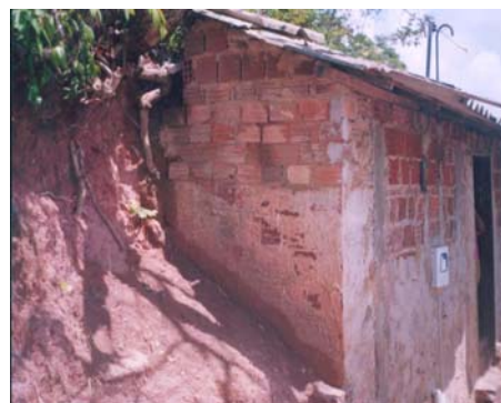
Figura 3- Ocupação irregular das encostas.
