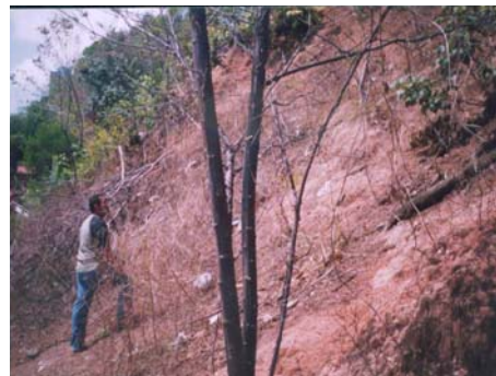
Figura 2- Deslizamento superficial causado pela remoção da cobertura vegetal.
