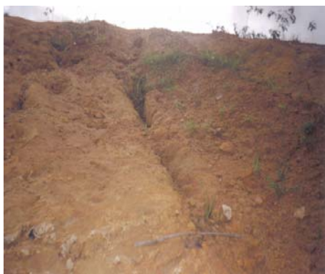
Figura 3- Evolução da erosão laminar para a forma da erosão em sulcos no sítio Açude Grande.
