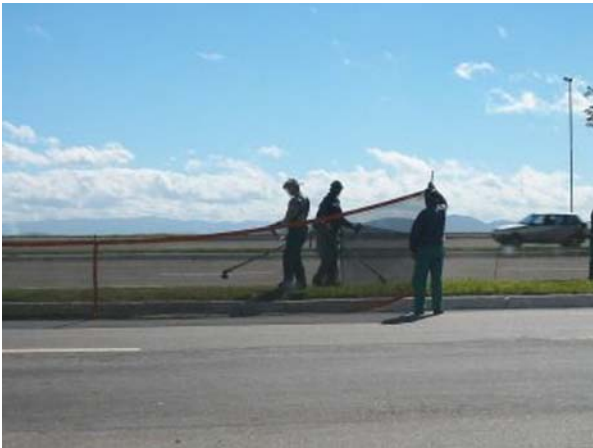
Figura 6: Enquanto o operador de roçadeira trabalha em um canteiro central, dois trabalhadores seguram uma tela de proteção em cada lado, ficando ao nível dos automóveis.
