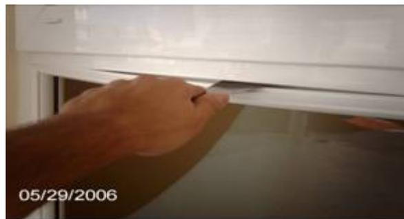
Figura 6: Foto ilustrativa da baguete desconectada.
