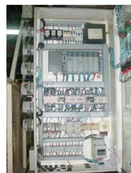
Figura 4: Novo painel do transportador aéreo de cabinas, após modificações apresentadas
