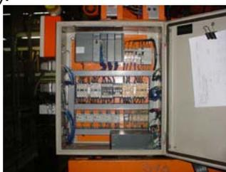
Figura 2: Painel antigo do transportador aéreo de cabinas com condições limitadas
