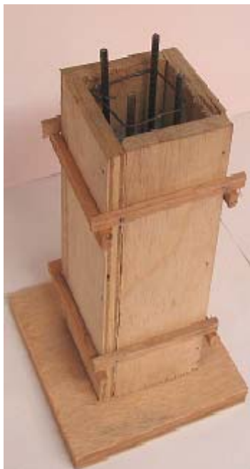
Figura 2- Modelo de fôrma de pilar com as armaduras posicionadas e fixadas no interior das fôrmas [executado pelos alunos].
