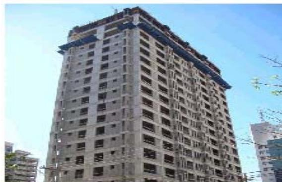
Figura 7: Foto do edifício – Em toda sacada foi utilizado massa com o entulho reciclado
