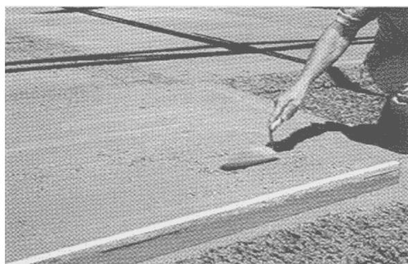
Figura 6: Argamassa produzida à partir da reciclagem do entulho sendo utilizada no subsolo do prédio como pavimento.
