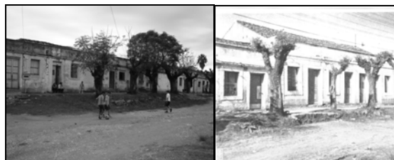
Figura 2 - Foto da Vila dos operários. Conjunto de casas localizados em frente a charqueada e Foto do Armazém de Silvério de Souza.
